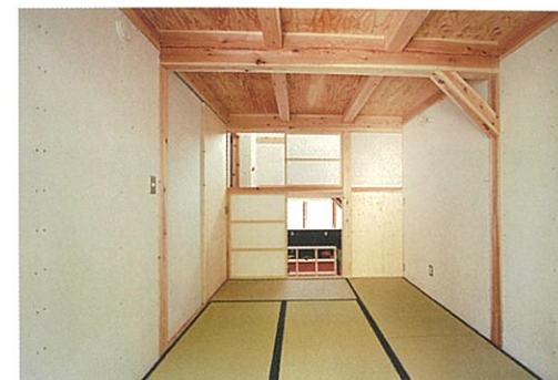
2階の主寝室の構造は露しとなっている
