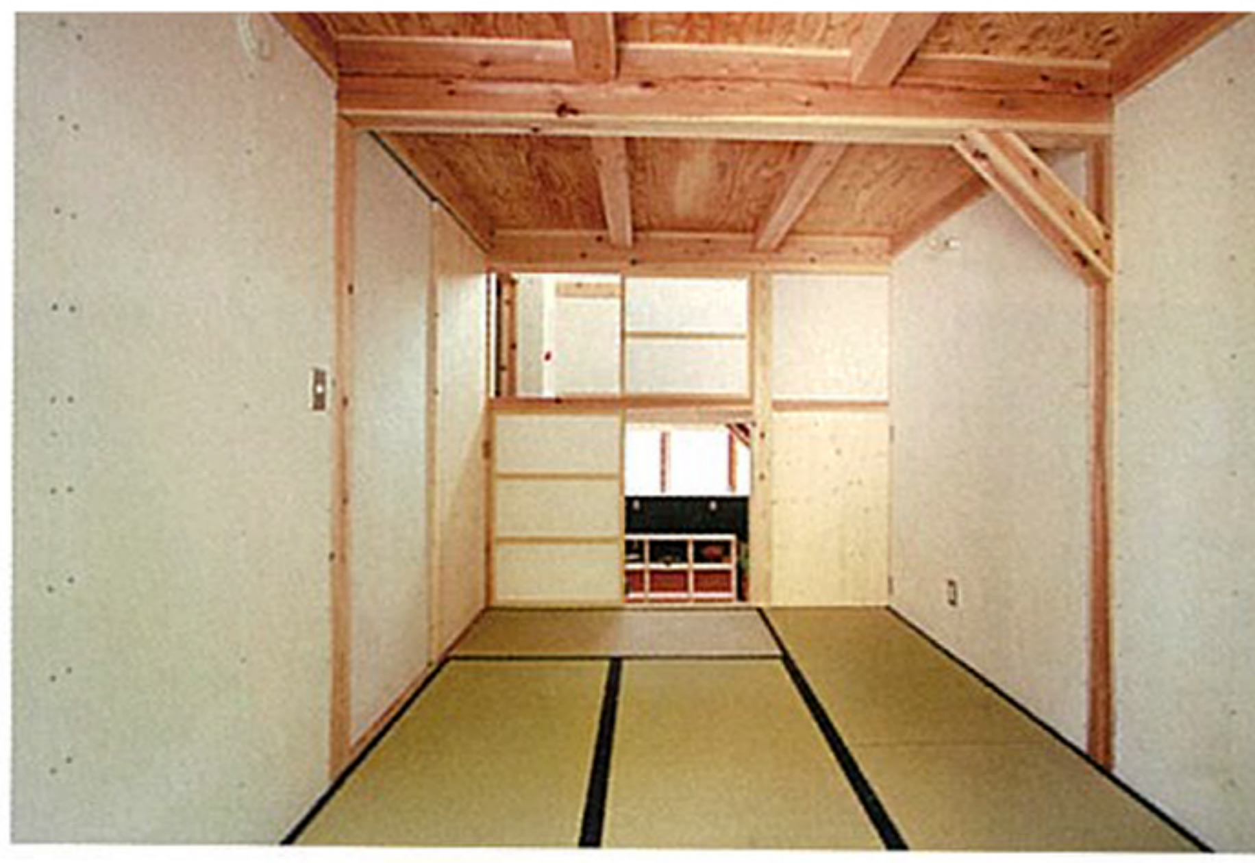
2階の主寝室の構造は露しとなっている
