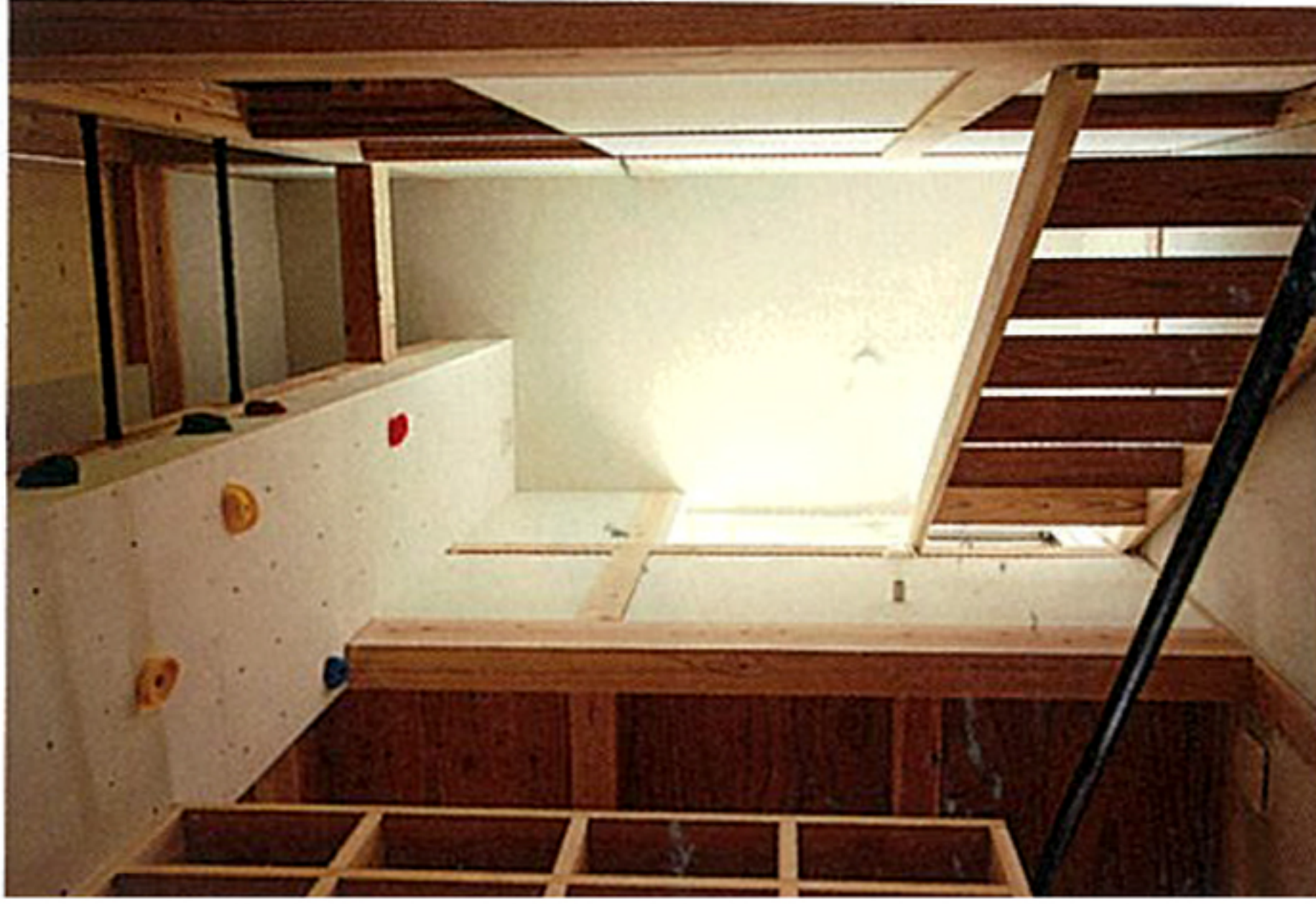
リビングから、吹抜けを見上げる。跳ね上げ屋根のハイサイドライトから自然光が差し込む。夏は熱気を排出し、冬は吹抜け上部のファンで頂部に溜まった暖気を床下を送る
